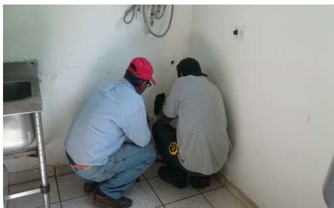
Reparaciones en establecimientos educacionales.
