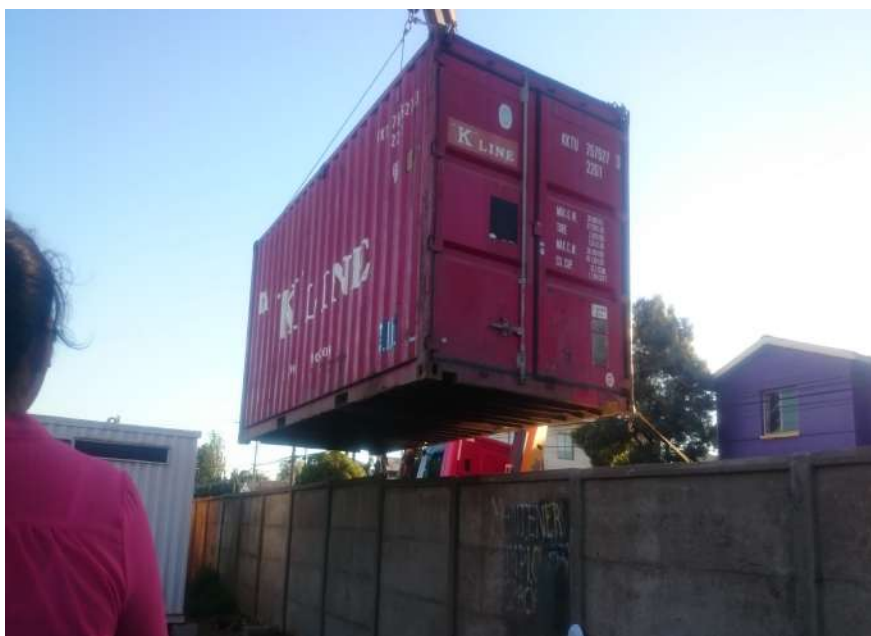
Instalación contener en Municipalidad.
