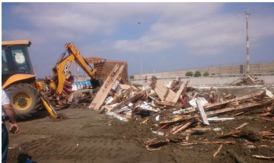
Limpieza y retiro de embarcaciones varadas en playa albatros.
