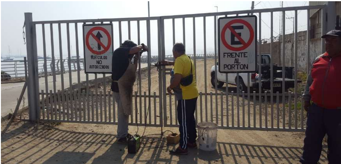
Diseño, construcción e instalación de cierres y portones para recintos municipales.
