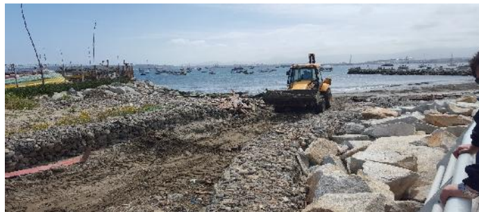
Limpieza canales de agua lluvia bordes costeros, con maquinaria pesada y camiones tolva.
