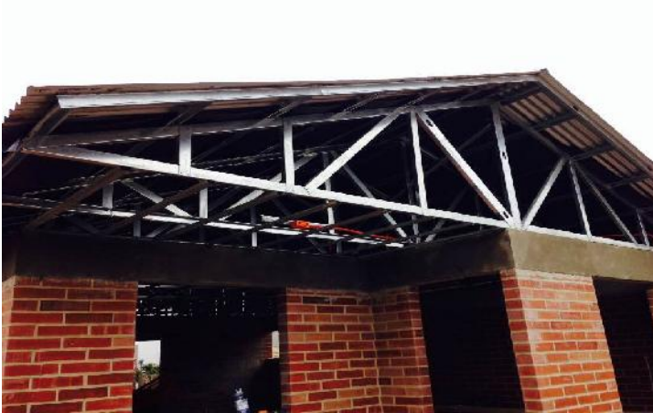
Visita Construcción en Sitio Propio, Comités Costa del Mar y Jerusalén.
