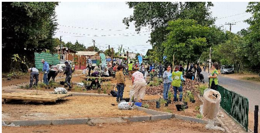
Trabajo de Proyección y construcción Plaza La Unión de Loncura, sector Av “El Bosque”
