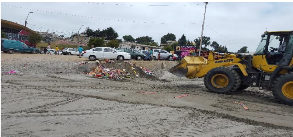
Limpieza de y mantención de zonas de divertimento y esparcimiento.
