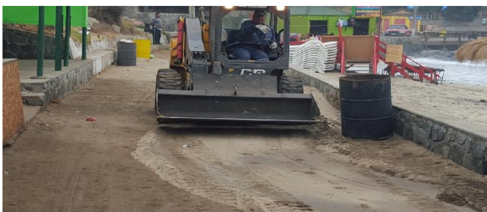
Mantencción de los accesos peatonales y reparación de estos en los bordes costeros de toda la comuna.-
