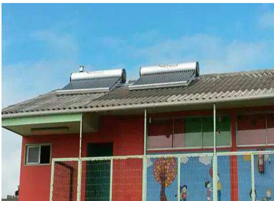
Instalación de Paneles solares
