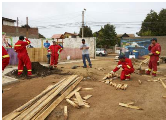
Trabajos realizados por GNL
