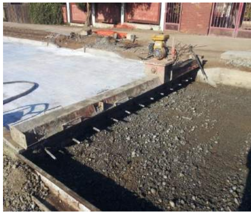
Foto 4: Construcción de juntas
