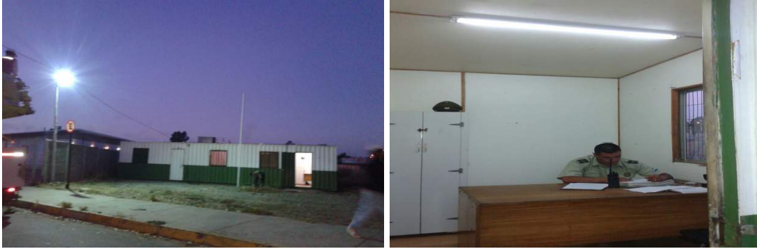
Trabajos terminados, iluminación exterior y electricidad interior para funcionamiento del container.
