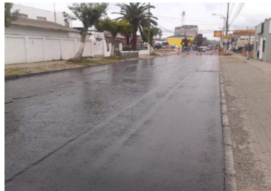
Foto 4: Imprimación Viaprime
