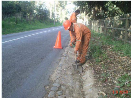
Limpieza Manual de la Faja Ruta F-216 (Acceso a Valle Alegre)
