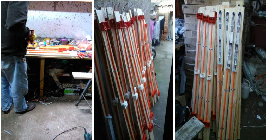
Trabajos de Armado de los Módulos Eléctricos (61) en Taller particular de Contratista
