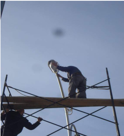
Montaje de 2 nuevas luminarias (Haluro Metal) en poste ubicado en punta diamante
