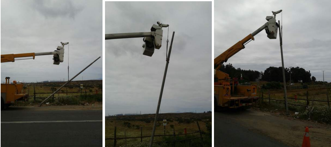
Faenas de montaje de Poste Metálico acceso valle alegre.
