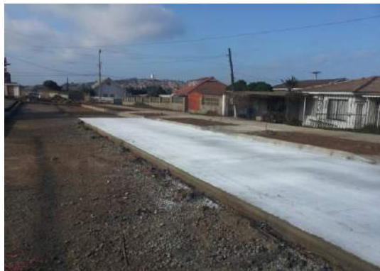
Foto 1: calzada de hormigón
