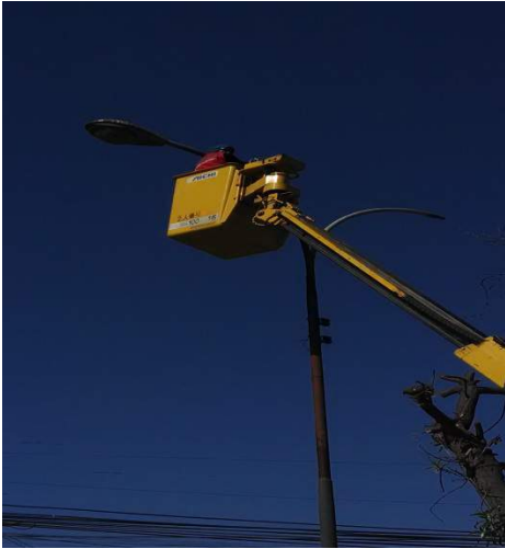
Trabajos de Montaje de Nuevo Gancho, en poste ubicado en punta diamante de esta plaza.
