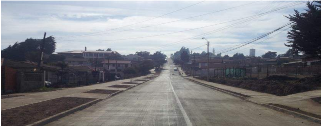
Foto 5: Vista General Calle Colon entre Balmaceda y H. Carrera.
