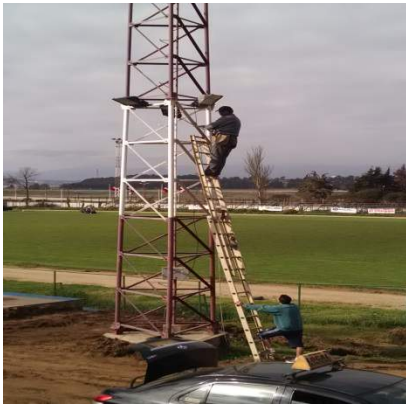
Faenas de Montaje de Proyectores para Iluminar Talud Explanada y Montaje de Proyectores para Iluminación Exterior Block J.
