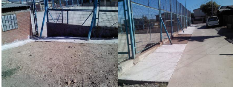
“Pavimento exterior multicancha población Lord Cochrane
