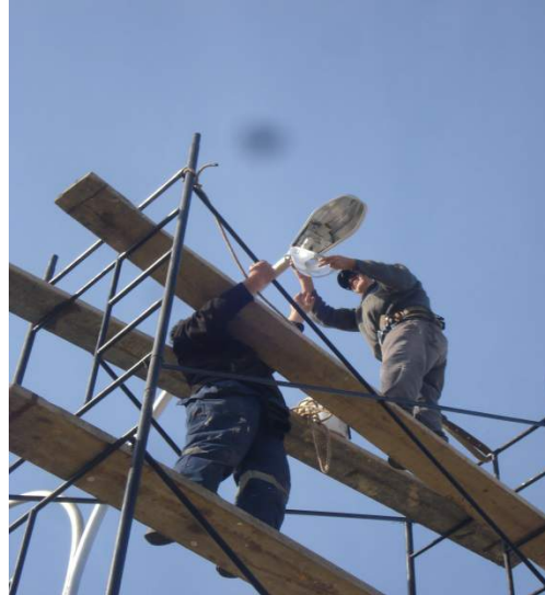
Montaje de 2 nuevas luminarias (Haluro Metal) en poste ubicado en punta diamante
