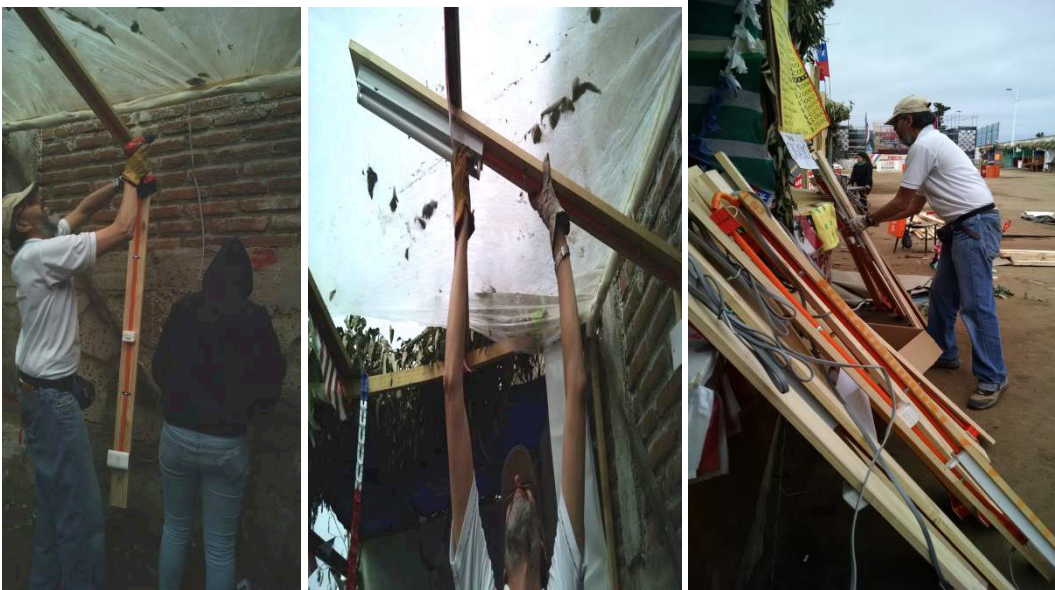
Trabajos de Desmontaje de los Módulos Eléctricos (61) al día siguiente de finalizado el evento.
