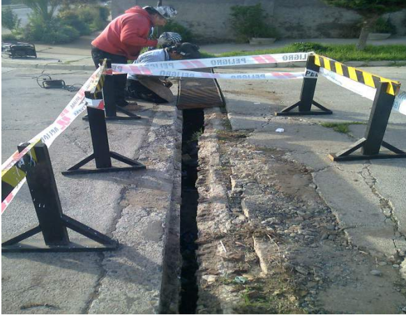
Reparación de rejillas colectores de aguas lluvias
