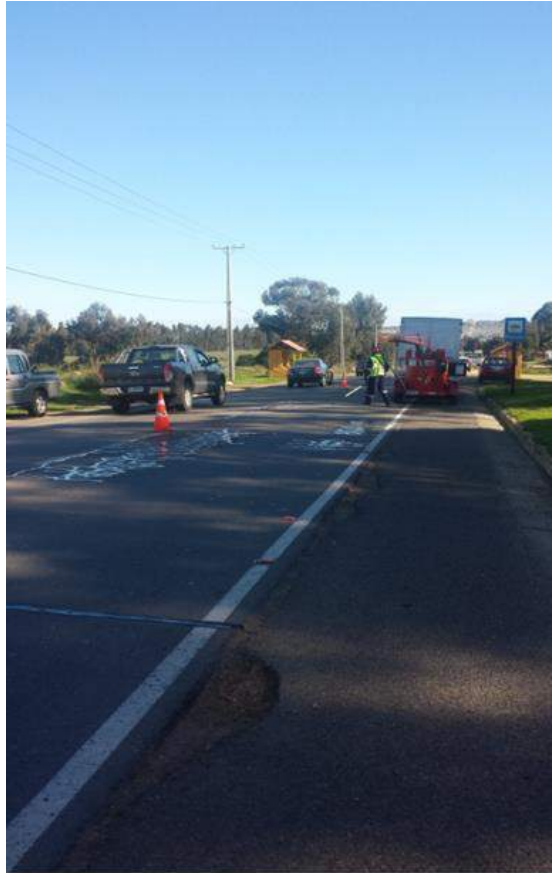
Sellado de Juntas y Grietas Ruta F-210 (Acceso a Quintero)
