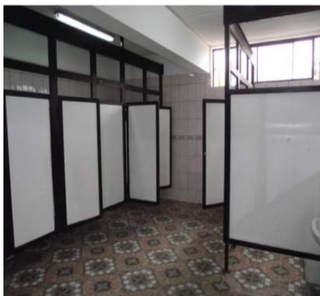
Reparaciones Escuela República de Francia y Liceo Politécnico Quintero
