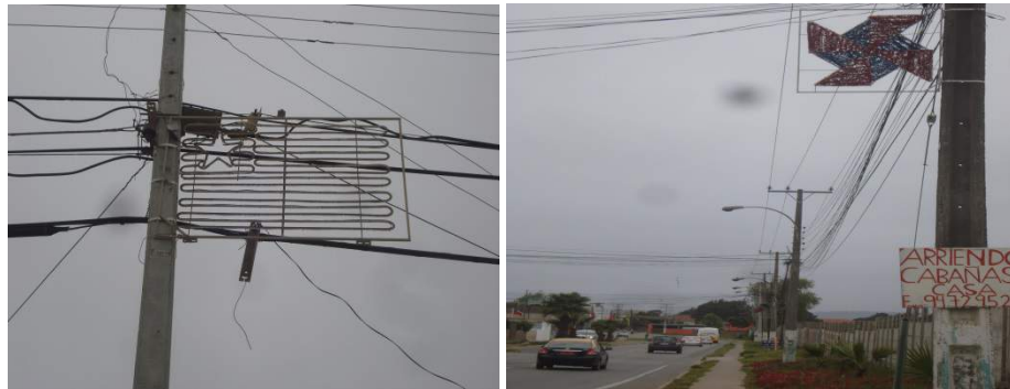
Adornos Instalados en Av. Normandie desde calle Vicuña hasta calle Alonso de Quintero
