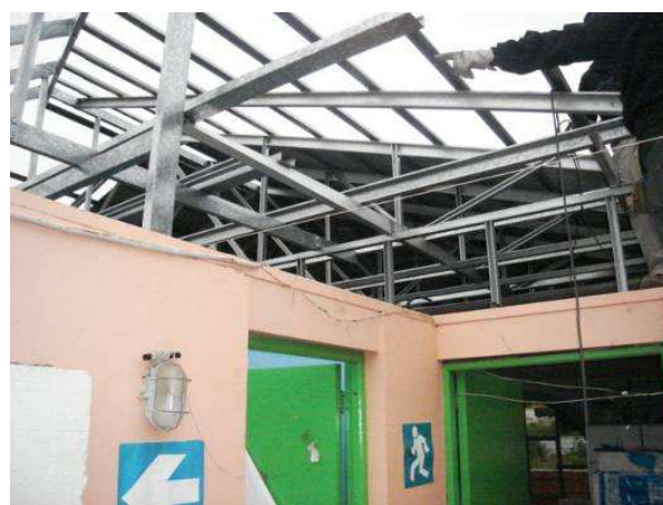
construcción de baño Manipuladoras e Instalación Eléctrica en sector de pasillo.
