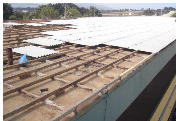
reparación de tabiques, pintura, instalación eléctrica de sala de clases, reparación de camarines, griterías e instalaciones sanitarias.
